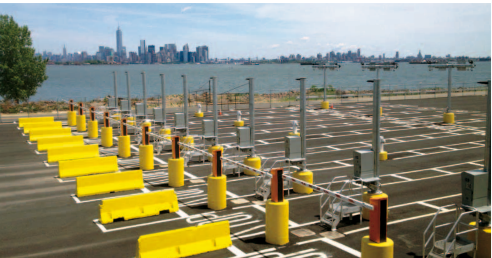
Шлагбаумы Magnetic.Access на бетонных стойках для контроля проезда грузовых автомобилей в Нью-Йорке (США).
